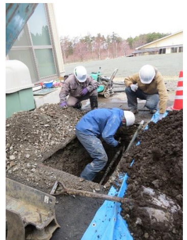
水漏れしているパイプを交換
