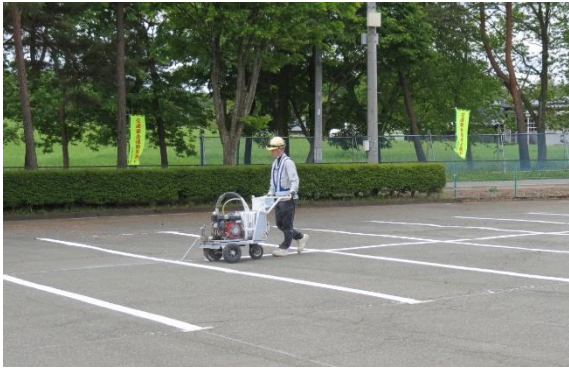
手押し、塗料吹き付け機械を操り、まっすぐな線を
