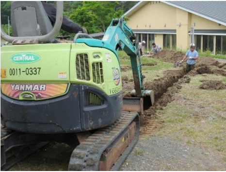
浄化槽電気ケーブル埋設工事
