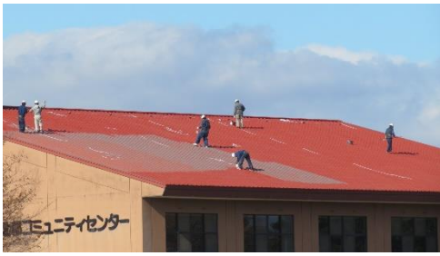
大集会室屋根のペンキ塗り替え（H25）
