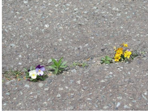
舗装の隙間にも。
