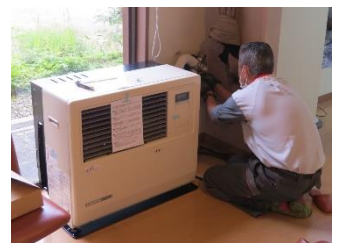
ストーブ入れ替え作業中
